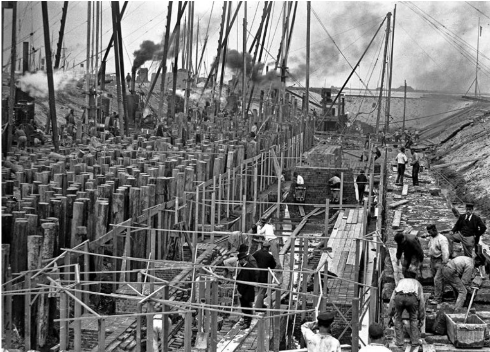
Afb. 1. De graansilo Korthals Altes aan de Westerdoksdijk in Amsterdam in uitvoering. De funderingspalen worden met stoommachines de grond in geheid. Foto: Jacob Olie, 10 september 1896. Collectie Stadsarchief Amsterdam.
